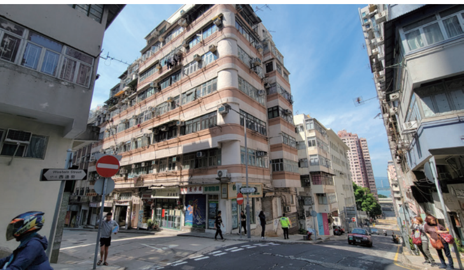
永豐樓現況。（編者攝於 2025 年）
